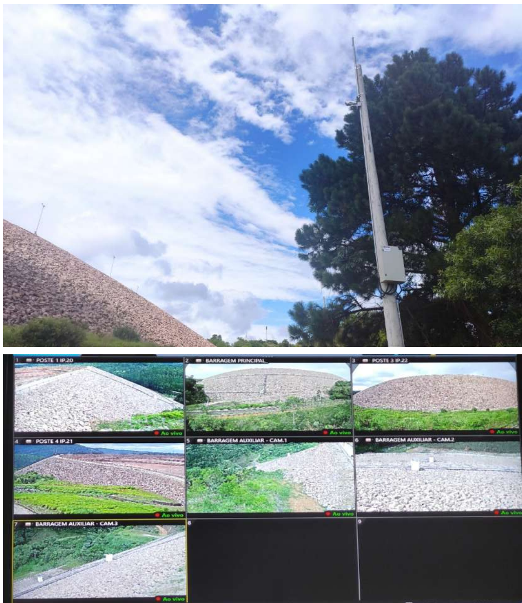
Figura 16.1 – Sistema de monitoramento da Barragem do Palmital – Câmera posicionada para o maciço e imagens das câmeras no painel da sala de controle.
