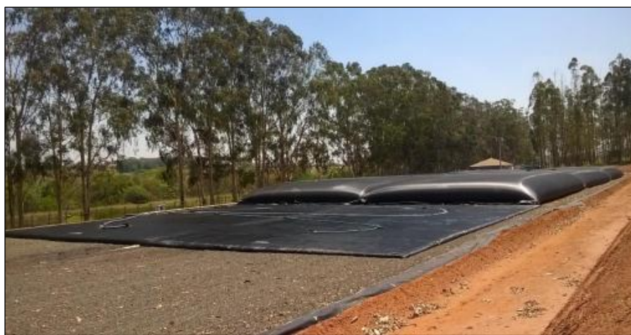
Figura 2-7 – Célula para assentamento do geobags .
