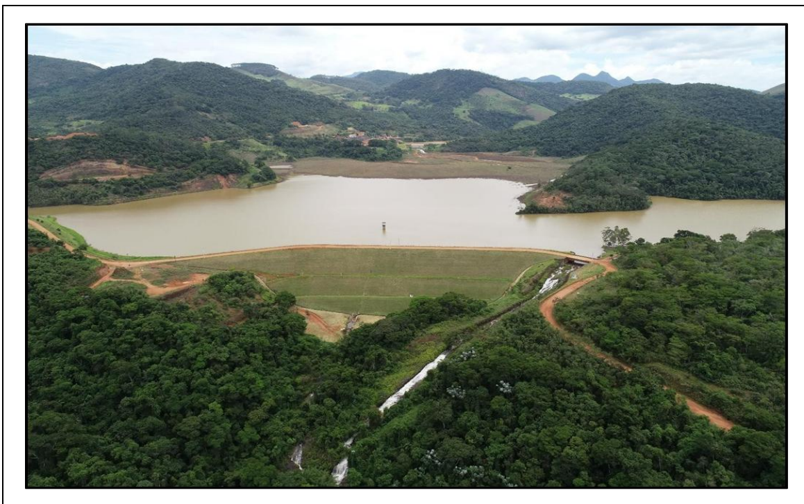
Figura 3.3 – Imagens aéreas da Barragem de Itamarati de Minas.
