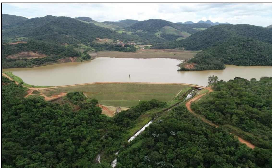
Figura 3-3 – Imagens aéreas da Barragem de Itamarati de Minas.
