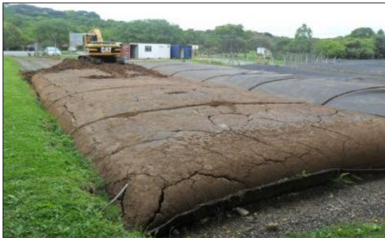
Figura 2-6 – Unidade de geobags aberta após o desaguamento.
