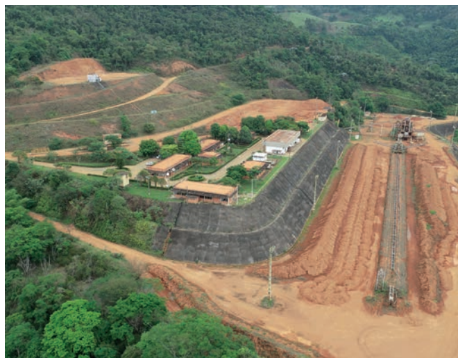
Unidade de Mineração de Itamarati de Minas
