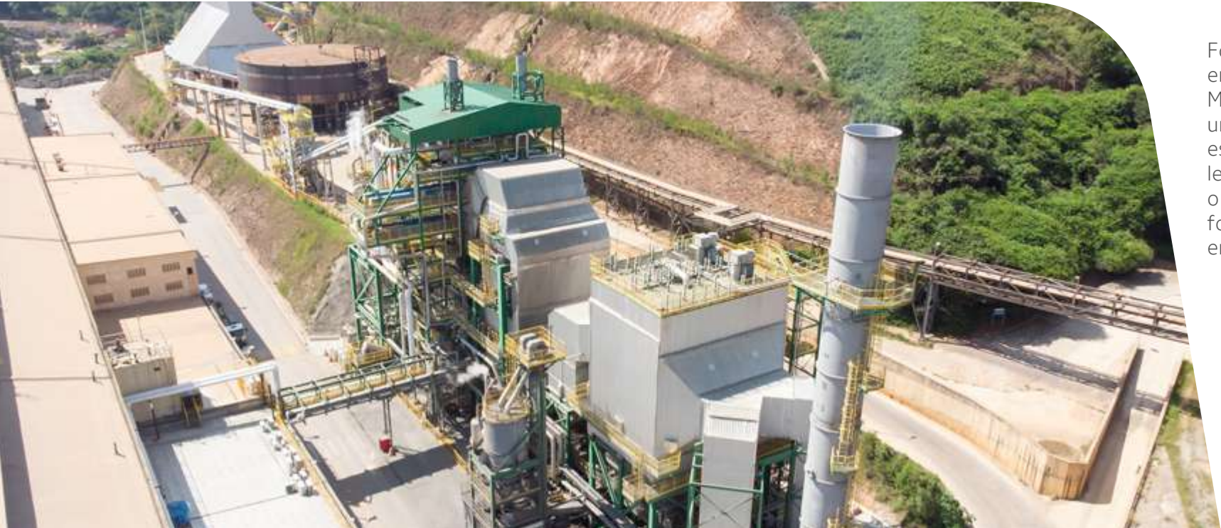
Caldeira à Biomassa para produção de vapor na área da Alumina
