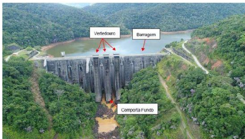
Figura 2 – Localização das Estruturas na UHE Barra
