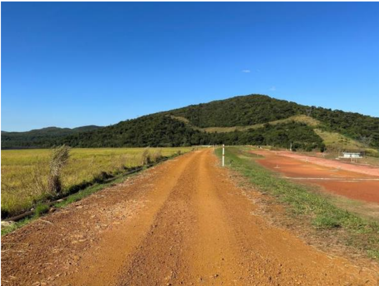
Figura 4.3 – Barragem do Jacuba - Vista para ombreira esquerda.
