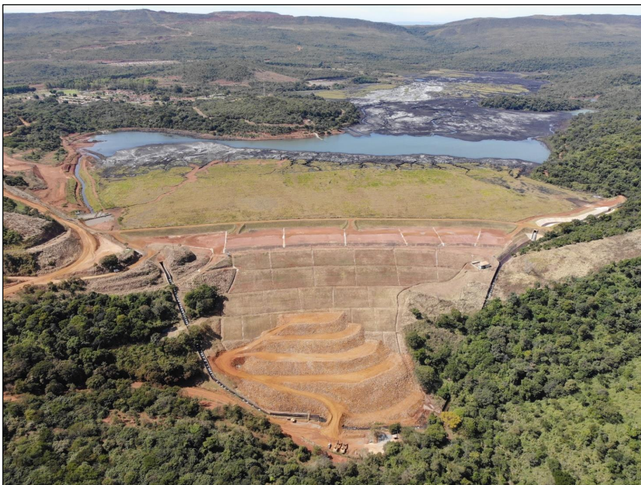
Figura 4.2 – Barragem do Jacuba - Vista do maciço. (Fonte: CBA,2022)
