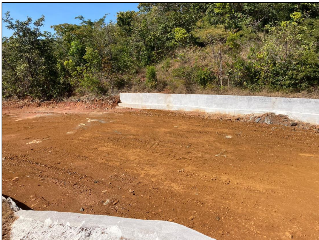
Figura 4-3 – Canal de aproximação do sistema extravasor da Barragem do Mosquito – 2022.
