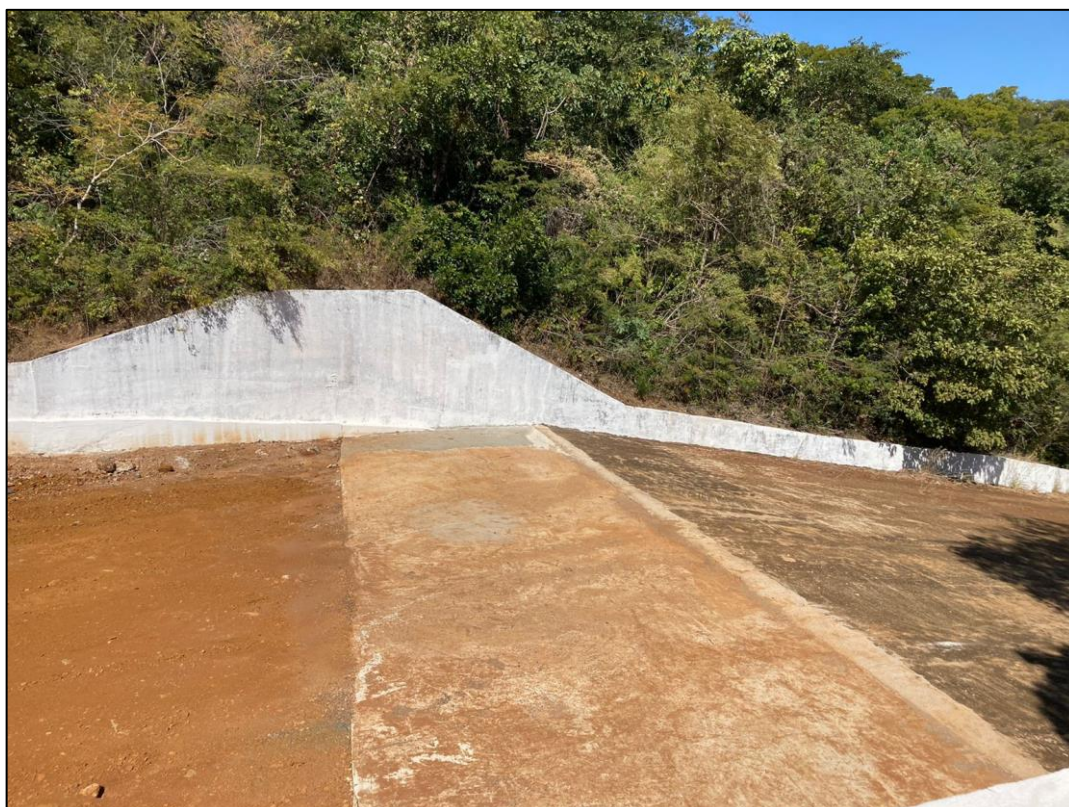
Figura 4-4 – Soleira livre do sistema extravasor da Barragem do Mosquito – 2022.
