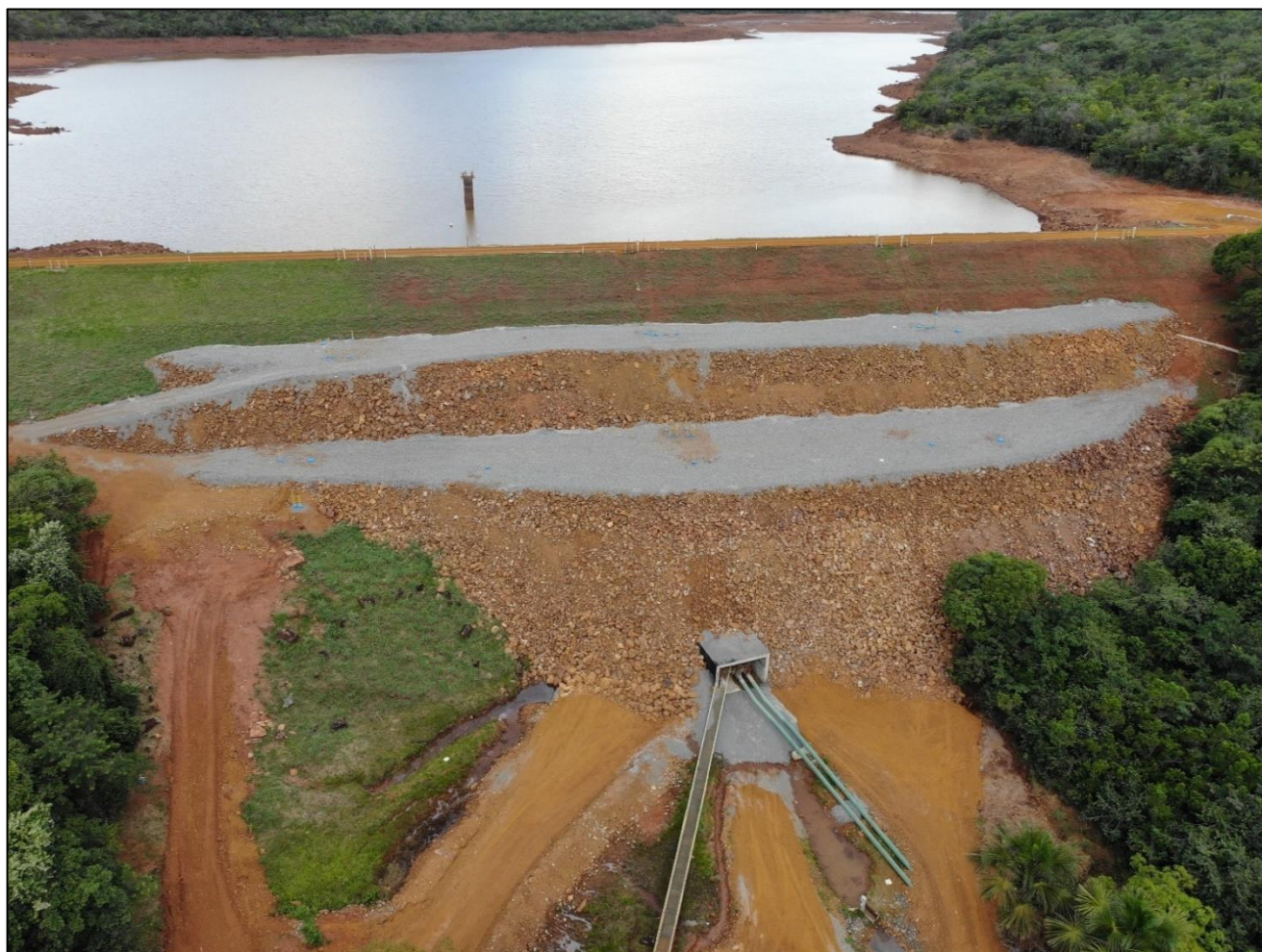
Figura 4-2 – Barragem do Mosquito - 2022.
