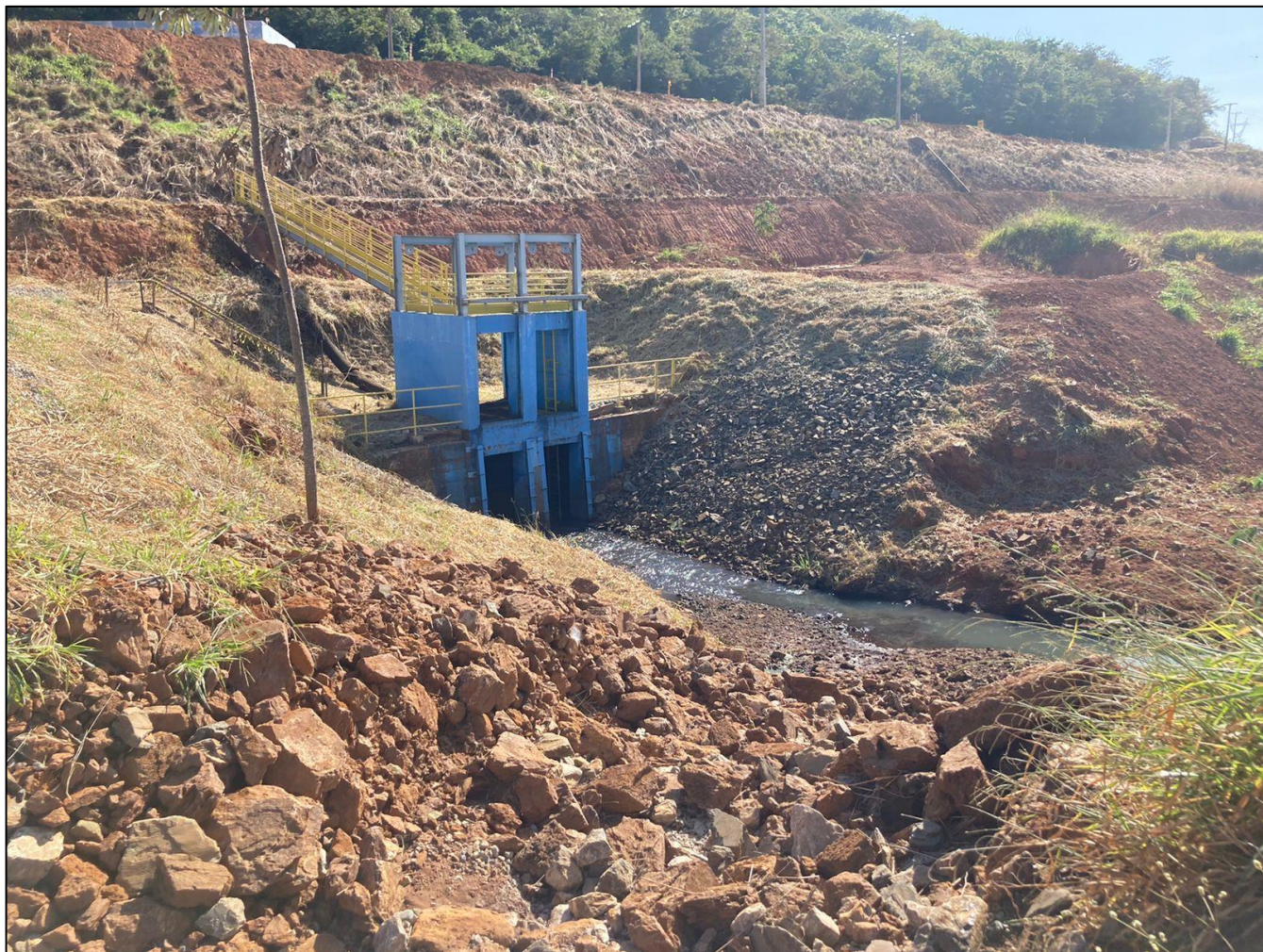
Figura 4-4 – Emboque do Extravasor. Visita de Campo em junho/2022.
