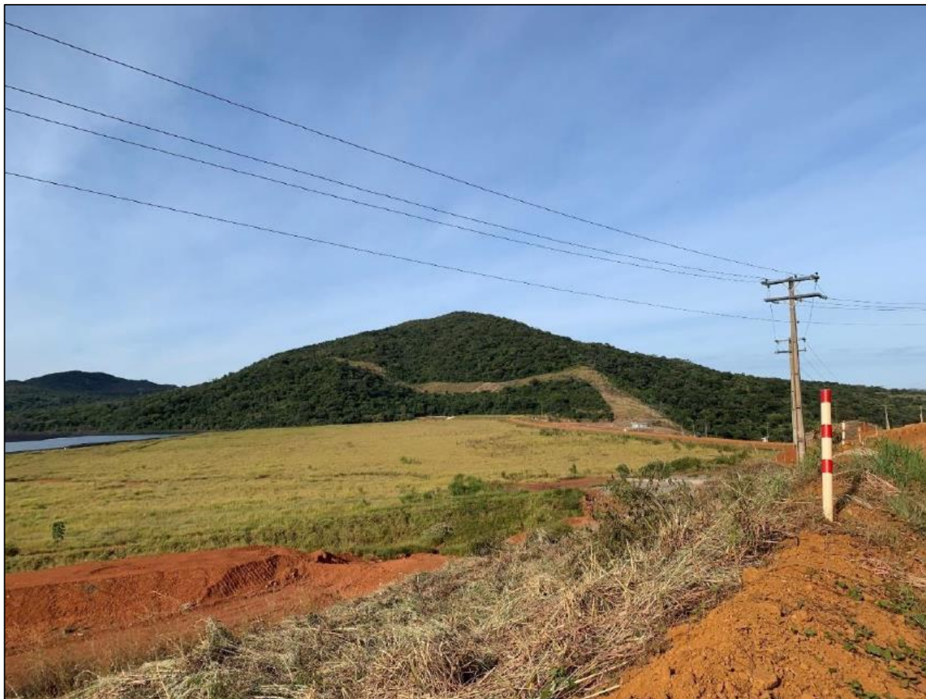
Figura 4-3 – Barragem do Jacuba - Vista para reservatório, crista e ombreira esquerda. Fonte: Relatório de Inspeção de Segurança Regular – RISR 2022 - NT03RT47.
