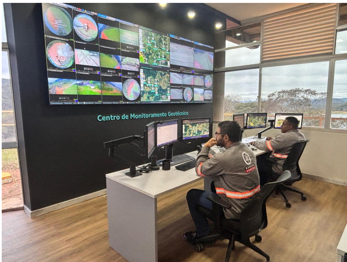
Figura 15.4 – Sistema de Monitoramento da Barragem de Rejeitos Mirai.
