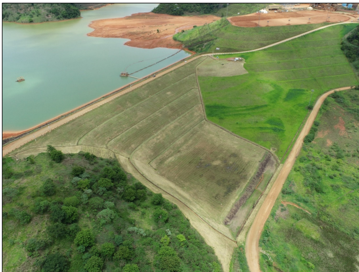
Figura 5-2 - Barragem de Rejeitos Mirai – Maciço Principal. Fonte: CBA, 2024.
