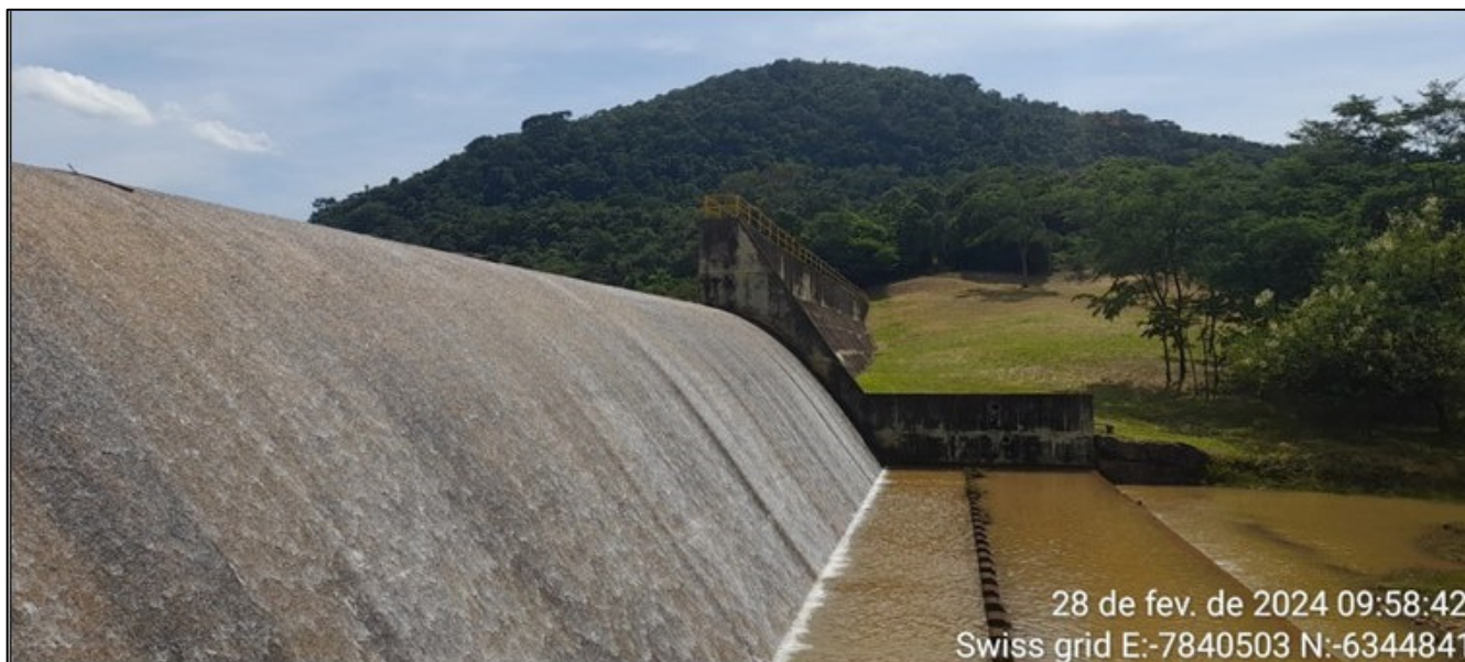
Figura 5.2 – Vertedouro da Barragem Água Limpa.
