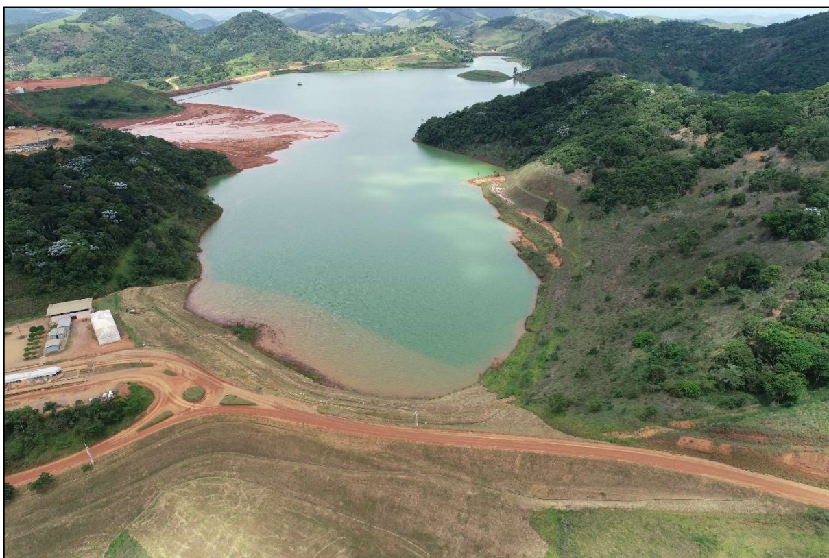
Figura 5-3 – Dique 1. Fonte: CBA, 2022.
