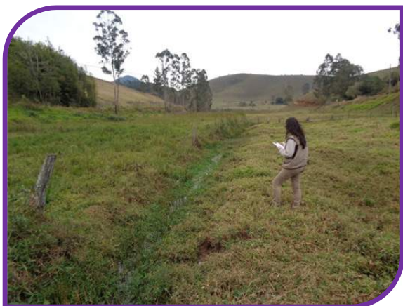
Drenagem típica da região
