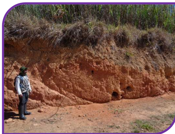
Perfil de solo na região do empreendimento
