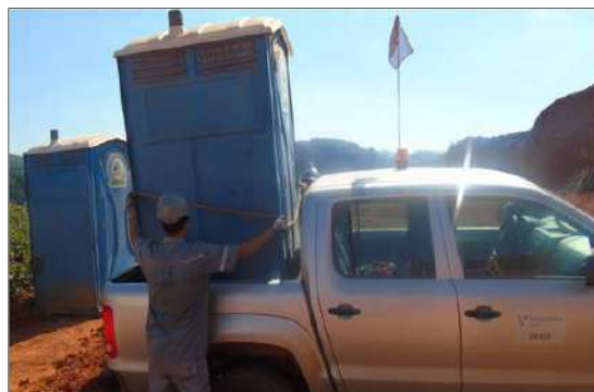
Foto 2.4.1-18 - Banheiro químico em processo de deslocamento para o ponto de apoio
