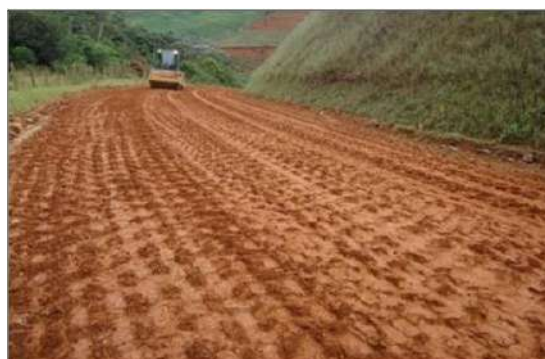
Foto 2.4.1-6 - Após o nivelamento o rolo compactador efetua a compactação do material
