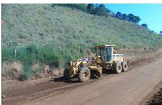
Foto 2.4.1-15 - Depois de construído o acesso a niveladora realiza o acabamento final
