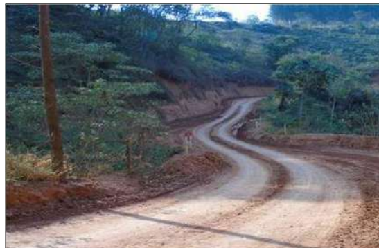
Foto 2.4.1-14 - Conforme indicado na foto os acessos devem possuir leiras de proteção de ao menos 1 metro
