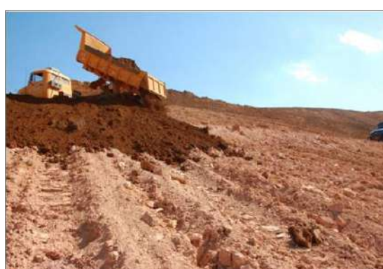
Foto 2.5-5 - Processo de espalhamento de top soil
