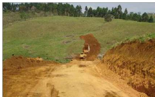
Foto 2.4.1-10 - Abertura do acesso com utilização de escavadeira e/ou trator de esteira
