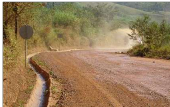
Foto 2.4.1-8 - De maneira conclusiva são realizadas as melhorias necessárias no sistema de drenagem dos acessos
