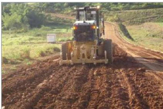
Foto 2.4.1-3 - Exemplo de obra de melhoria e alargamento de acessos existente, processo de escarificação
