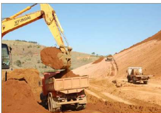
Foto 2.5-4 - Processo de espalhamento de top soil
