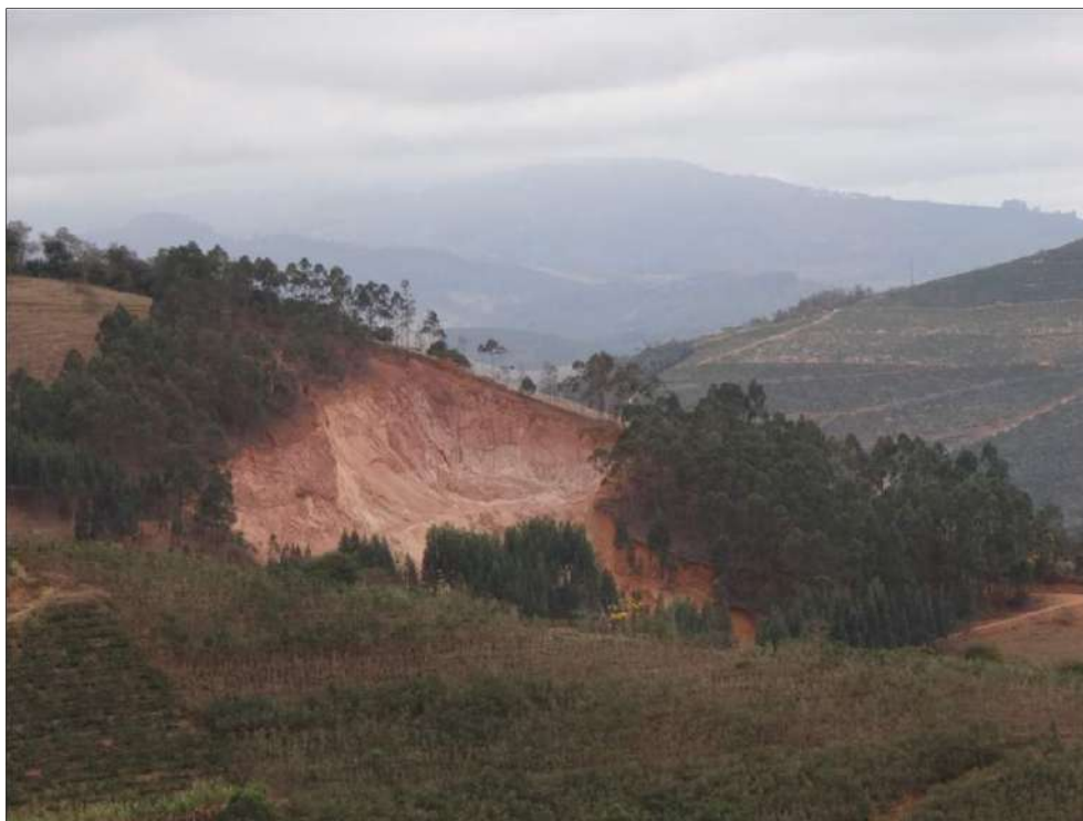
Foto 4.1.6-9 - Feição de deslizamento rotacional
