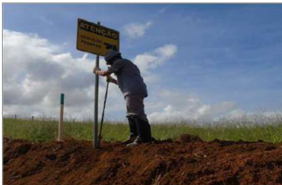
Foto 2.4.1-1 - Implantação de sinalização nos acessos utilizados pela mineração
