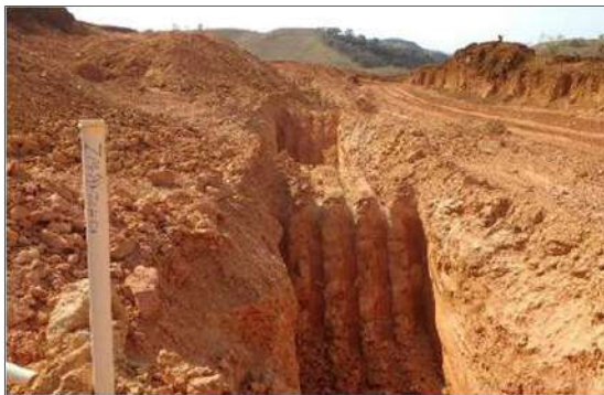
Foto 2.4.1-13 - Para os acessos são implantados sistemas de drenagem pluvial
