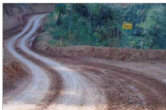
Foto 2.4.1-12 - Quando for recomendada, por questões sociais e/ou ambientais, largura menor que 8 metros, deverão ser alocados pontos de espera, conforme apresentado
