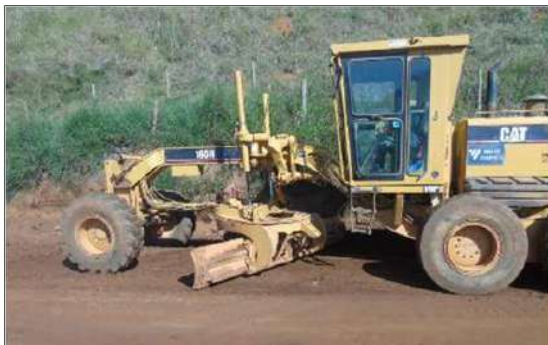
Foto 2.4.1-7 - Após a compactação a niveladora deve realizar o acabamento final
