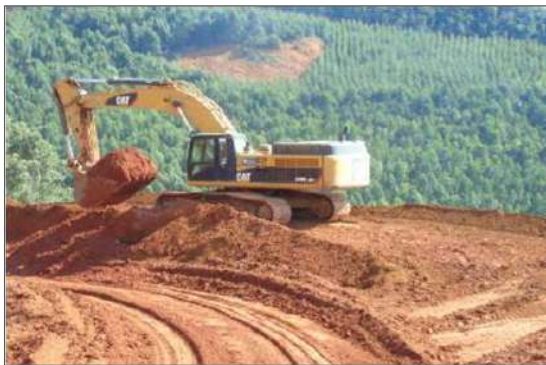
Foto 2.4.1-21 - Posicionamento da escavadeira no local onde será iniciada a escavação
