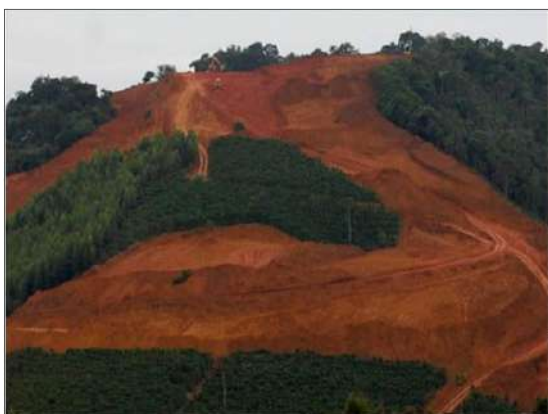
Foto 2.5-2 - Área da CBA em processo de reabilitação
