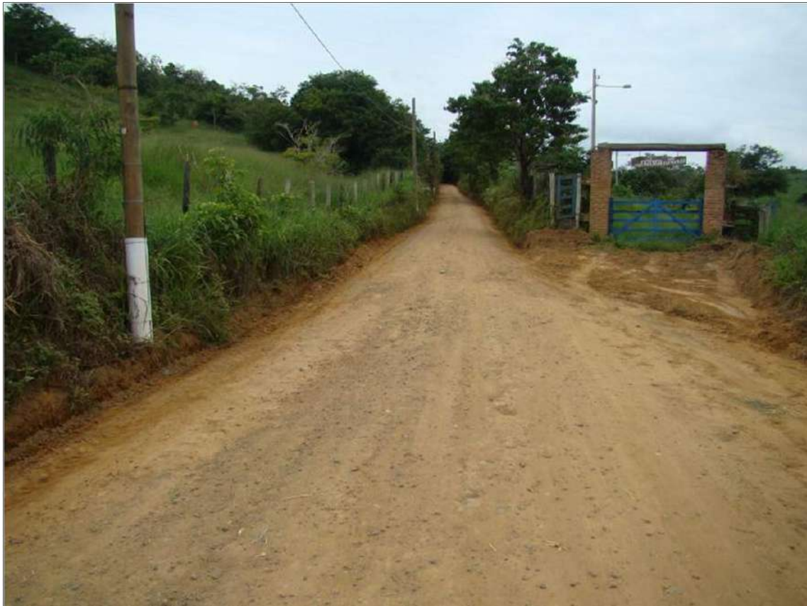
FIGURA 4.4.6-7 - Entrada do Assentamento Dênis Gonçalves em Goianá - MG
