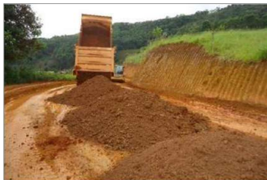
Foto 2.4.1-4 - Após a escarificação é espalhado material na via
