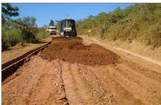
Foto 2.4.1-5 - O material é uniformizado e o terreno nivelado com moto niveladora
