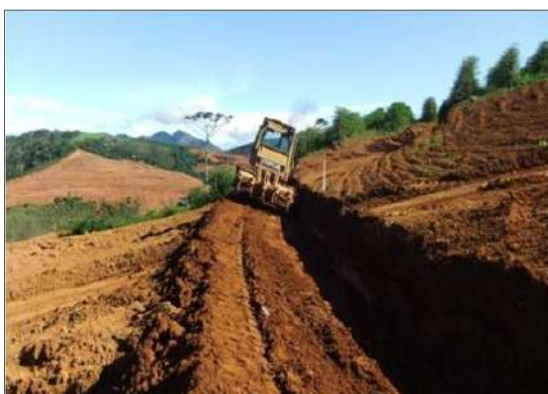
Foto 2.5.1-5 - Processo de abertura de curvas de nível
