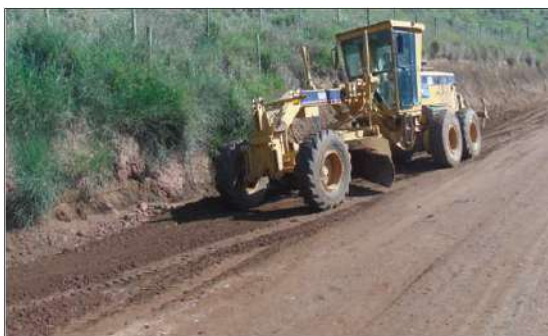
Foto 2.4.1-17 - Máquina e implemento utilizados para nivelamento do local de instalação do ponto de apoio
