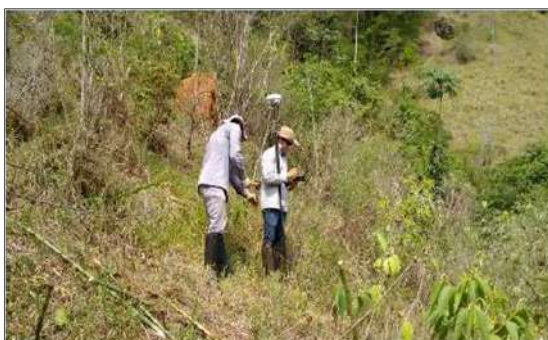
Foto 2.4.1-9 - Demarcação topográfica do novo acesso
