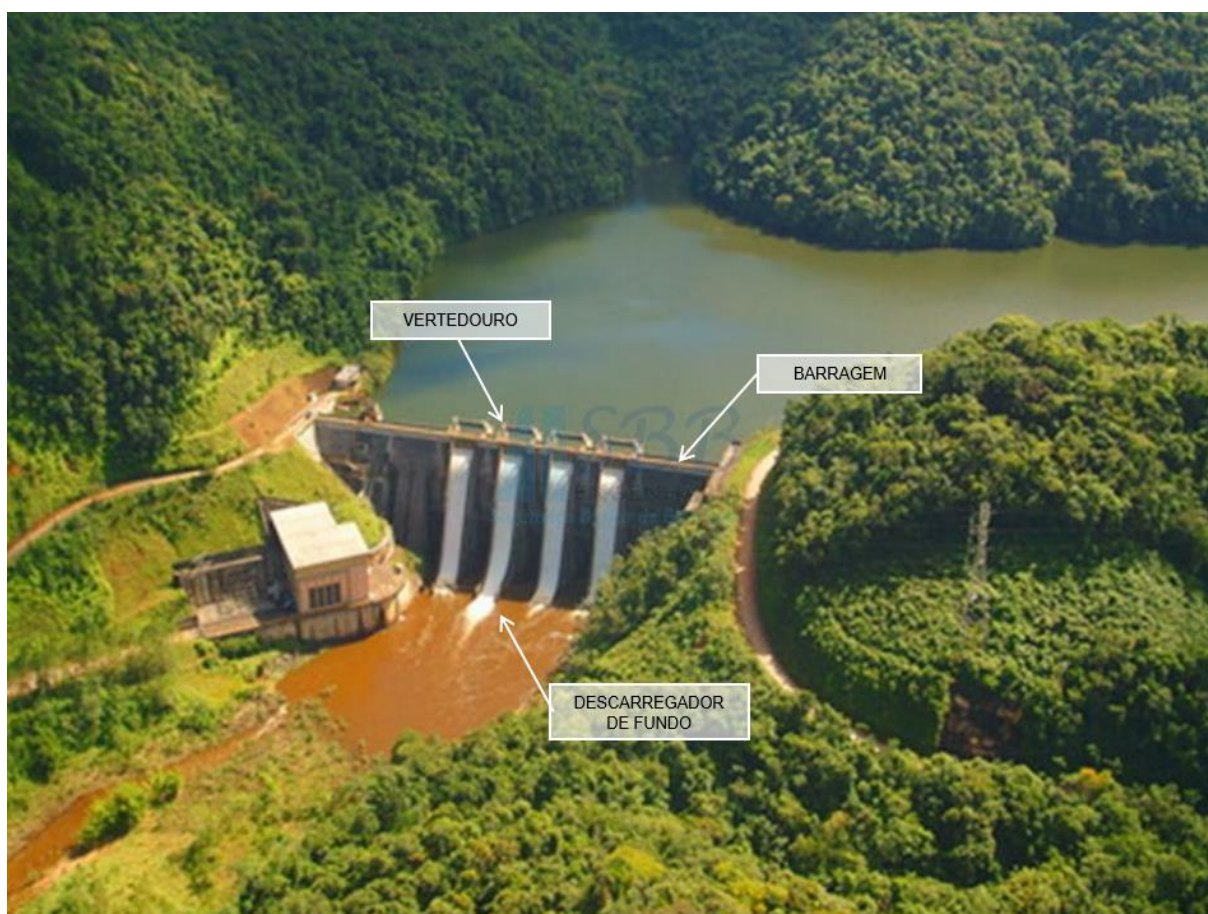
Figura 2. UHE Serraria – Barragem Vista Jusante.
