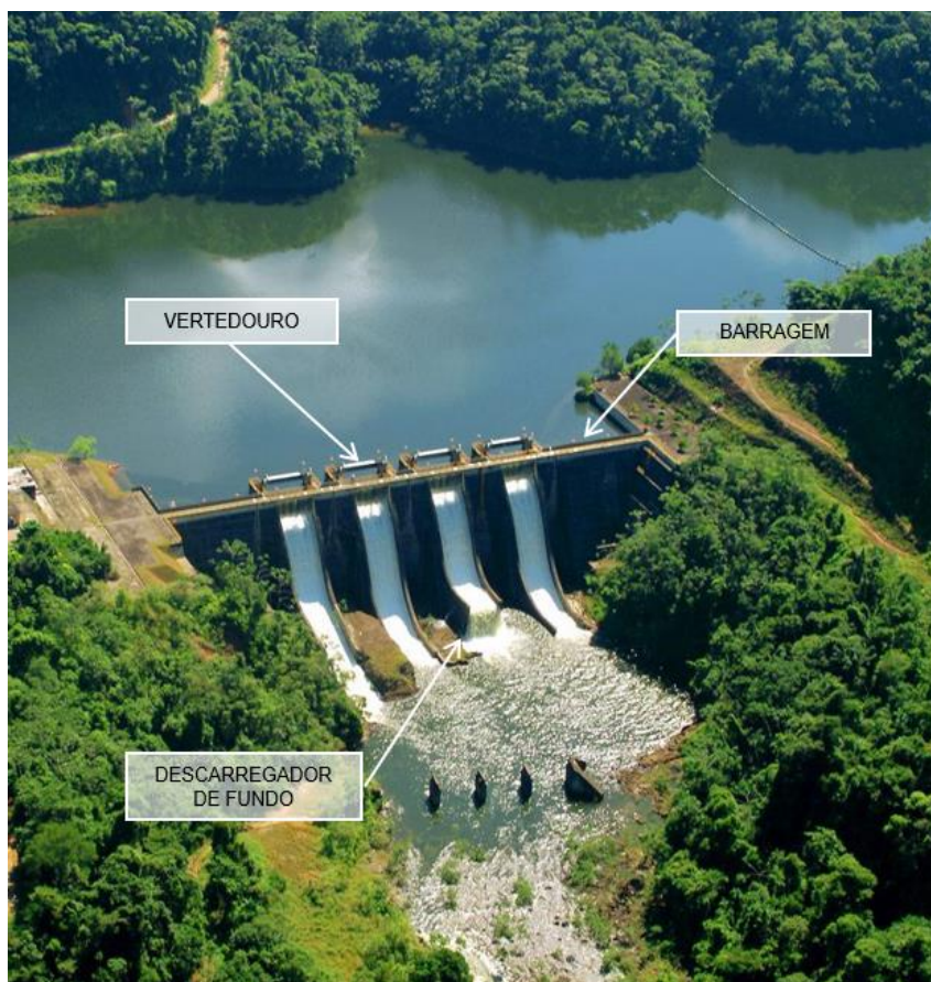
Figura 2. UHE Porto Raso – Barragem Vista Jusante.
