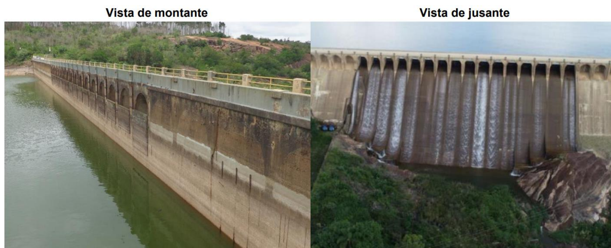
Figura 7. Vertedouro de Superfície da UHE Itupararanga.
