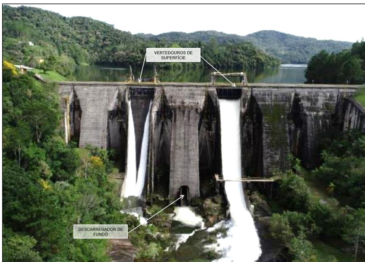
Figura 7. Vista de jusante dos dois Vertedouros de Superfície e do Descarregador de Fundo da UHE Fumaça.
