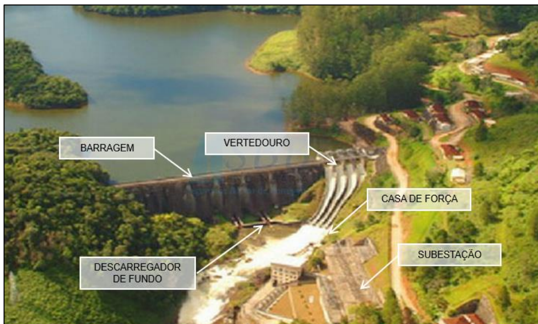
Figura 2. UHE França – Barragem Vista Jusante.
