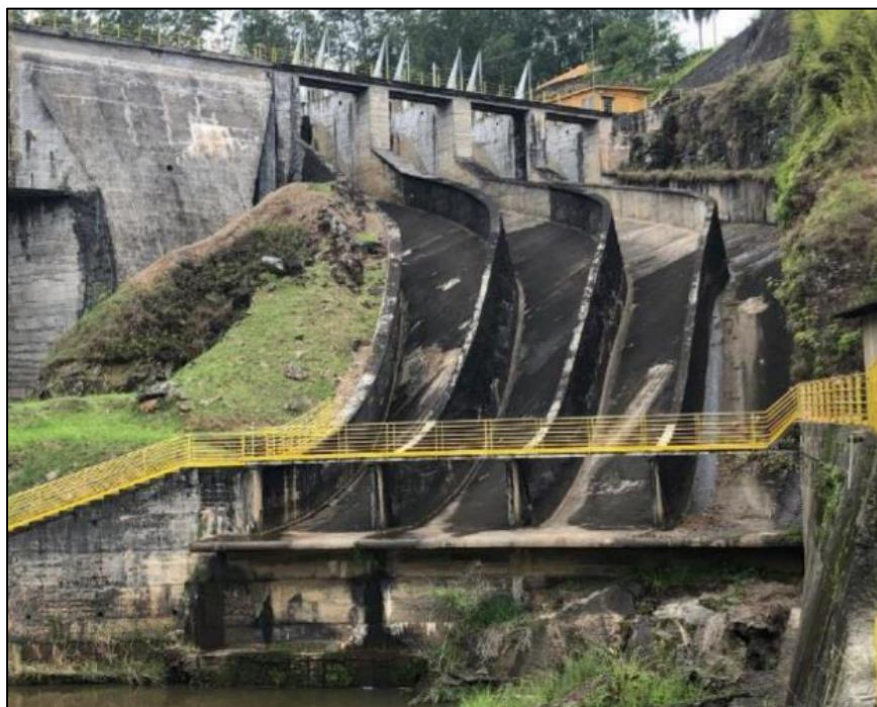
Figura 8. Vista de jusante do Vertedouro de Superfície da UHE França (foto).
