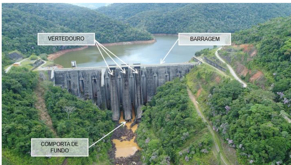
Figura 2. UHE Barra – Barragem Vista Jusante.
