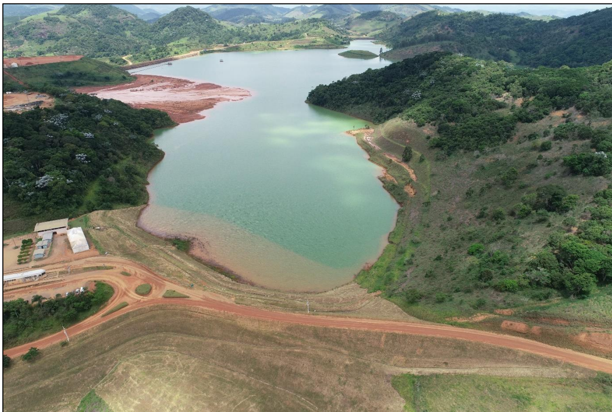
Figura 5-3 – Dique 1. Fonte: CBA, 2022.
