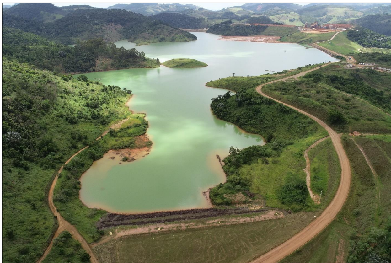
Figura 5-4 – Dique 2. Fonte: CBA, 2022.
